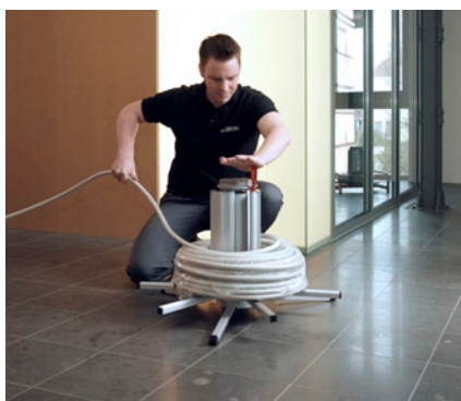
Fot. 5. Obrotowy stojak do odwijania kabli z krążków „w akcji”
